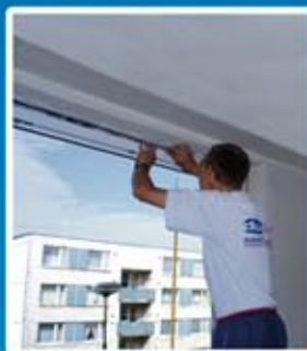
Pro správnou funkci systému DAFE 3P je nutné pásku aplikovat po celém obvodu montážní spáry
