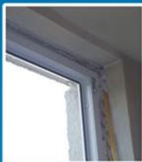
Detail okna s aplikovanou difuzní uzávěrou
