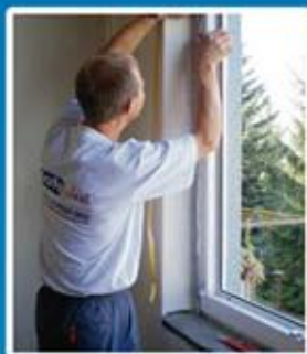
Aplikace vnitřní difuzní uzávěry
