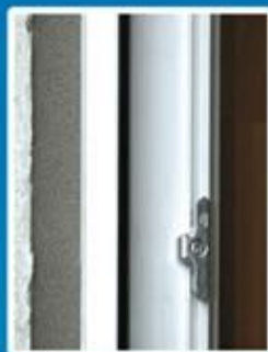
Použití komprimované pásky pro utěsnění venkovní montážní spáry
